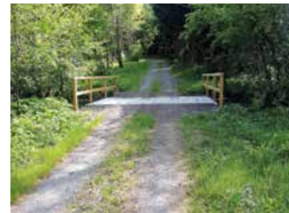
Die neue Brücke über das Schirnitzbachl in Salmannsdorf
