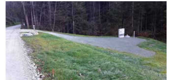
Der neue Brunnen und die neue Straße in Rotleiten.
